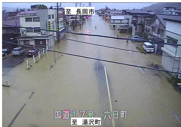
【写真①】現国道17号の冠水状況 南魚沼市六日町地先(7/30 7:30頃)
