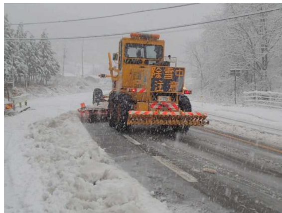
除雪作業状況 (除雪グレーダ)
