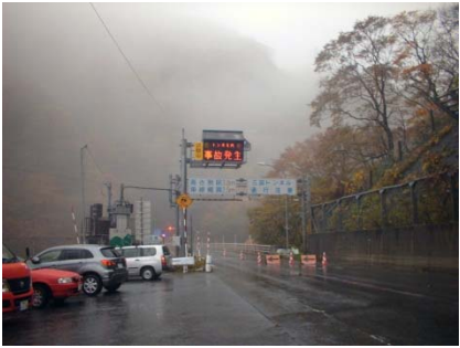
事務所の操作盤による 警報板表示切替訓練
