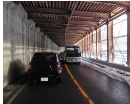
全面供用の状況
