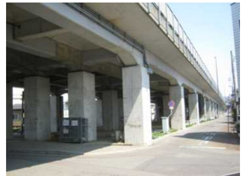
国道8号 長岡高架橋
