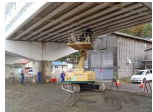
高所作業車を用いた点検(例)
