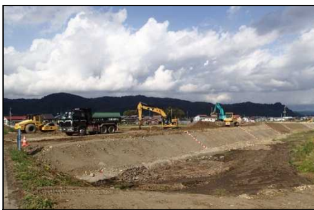
盛土工事が進む十日町地区
