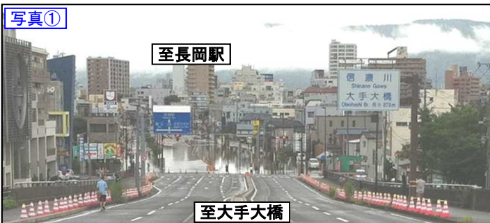
H23.7.30 浸水状況 大手大橋東詰(右岸側で発生した浸水により、通行止めが発生)
