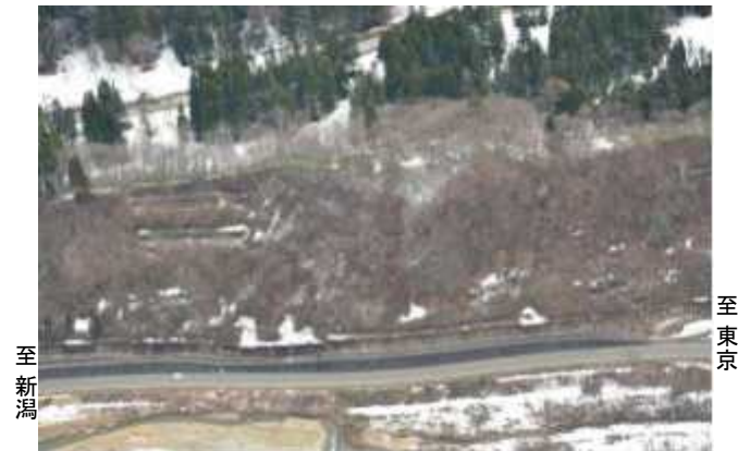
②湯沢町三俣地先(東電前斜面)
