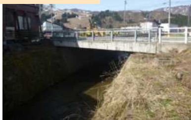
【国道17号 小黑橋 全景】
