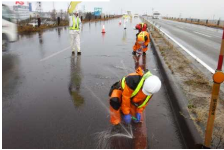
消雪パイプ点検
