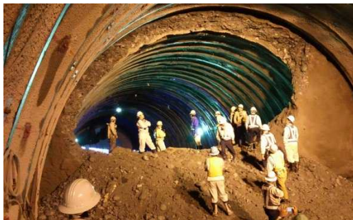
(仮称)八箇峠トンネル貫通(平成26年10月14日)
