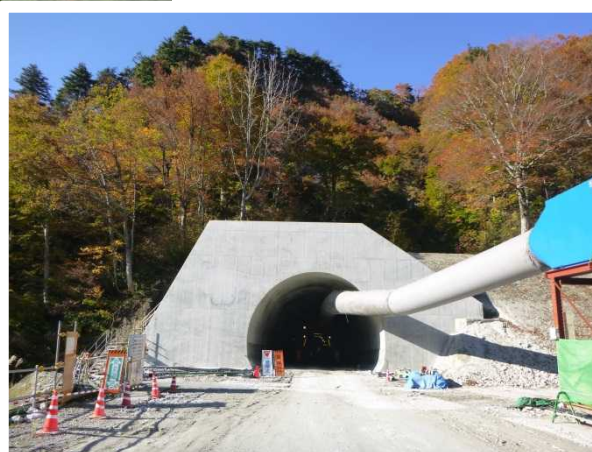
7号トンネル施工状況
