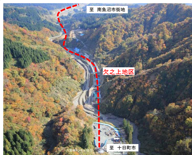
八箇峠トンネル坑口より南魚沼市街地方面を望む
