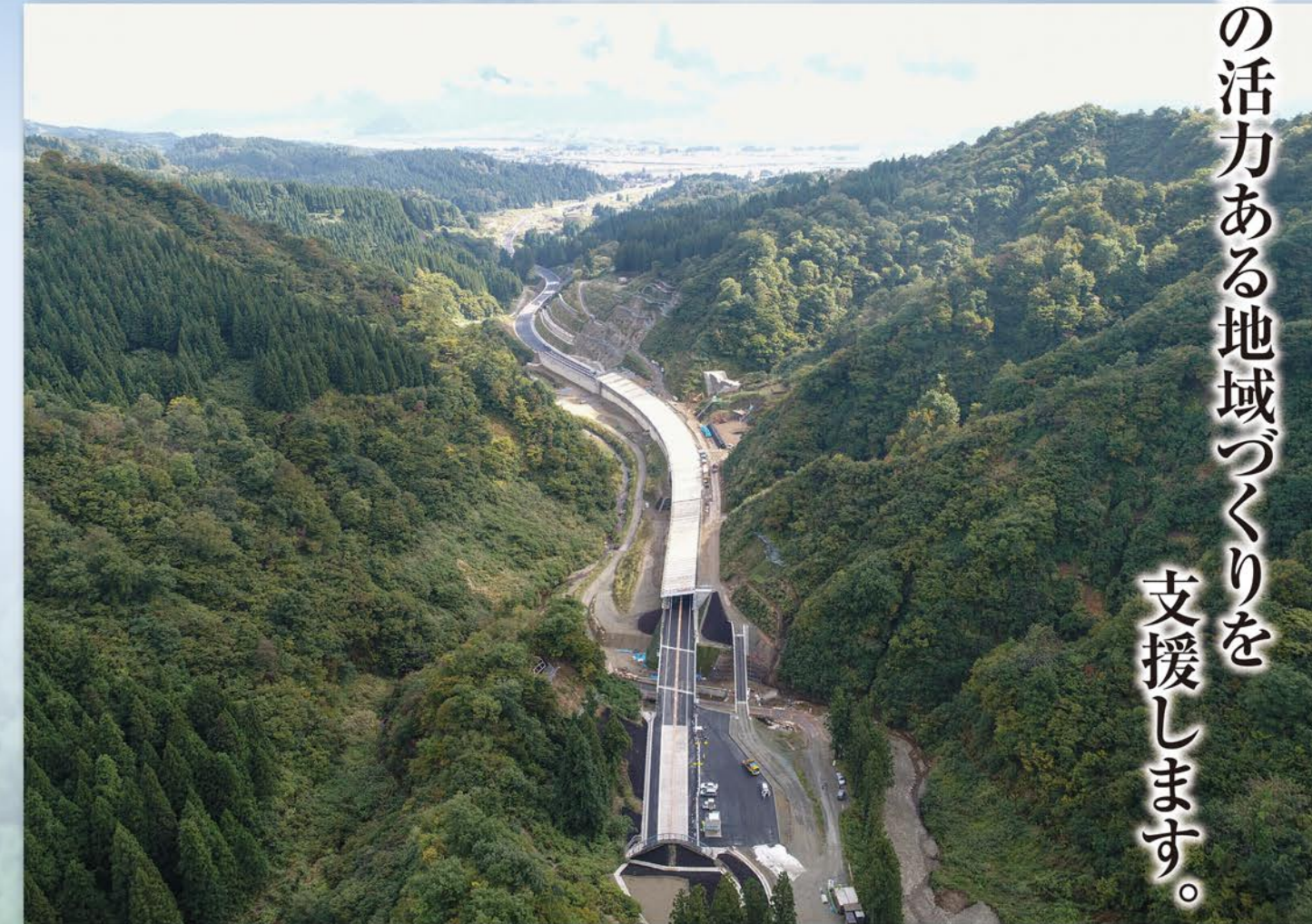
八箇峠トンネル南魚沼市側坑口から南魚沼市街地方面を望む
