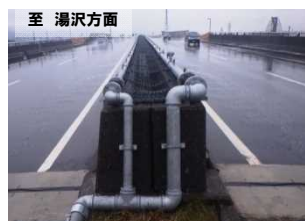
池之島高架橋(上り・下り)
