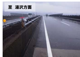
新組跨線橋(上り)
