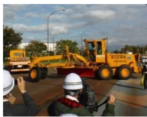
料金ゲート手前Uターン通過状況
