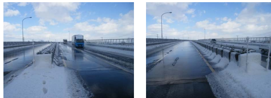
消雪パイプの設置イメージ (国道17号十日町高架橋)
