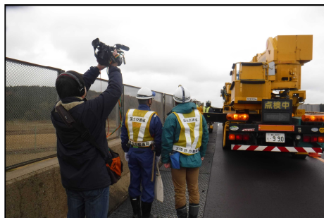
橋梁点検車の説明を受けるアナウンサー
