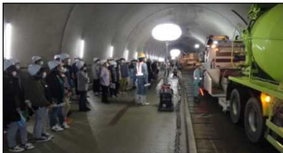
スリップフォーム工法を採用した八箇峠トンネルのコンクリート舗装工事
