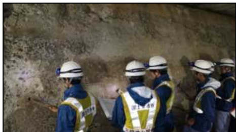
橋台点検でハンマー打音点検実習の生徒
