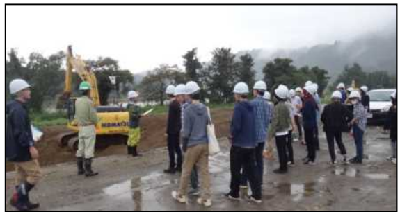
情報化施工技術を活用したバックホウによる築堤工事
