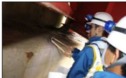
橋台点検でハンマー打音点検実習の生徒
