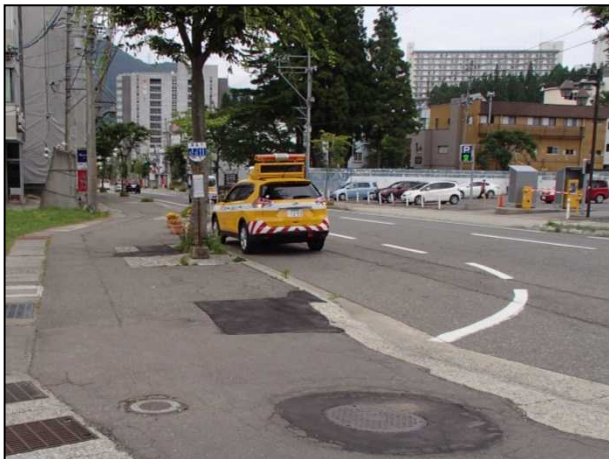
歩道の段差解消
