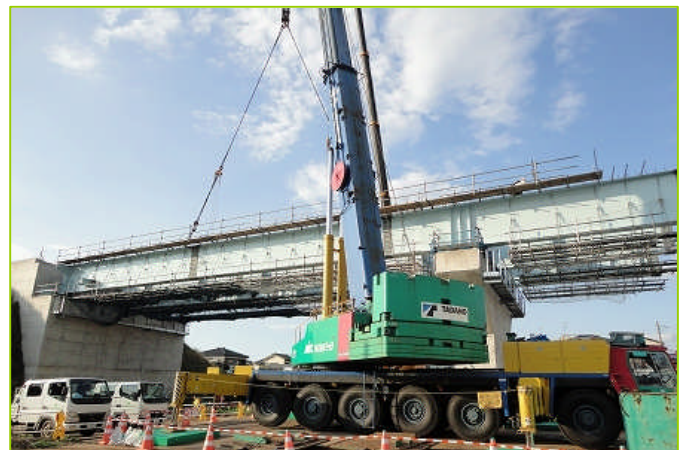
200t吊りトラッククレーンでの架設作業
