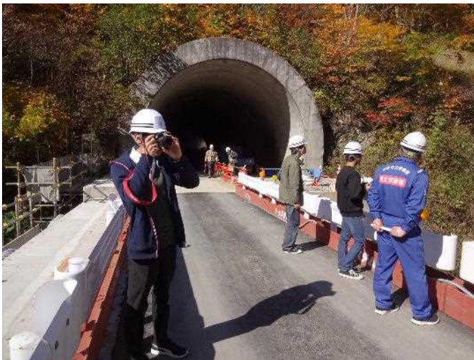
8号トンネル付近
