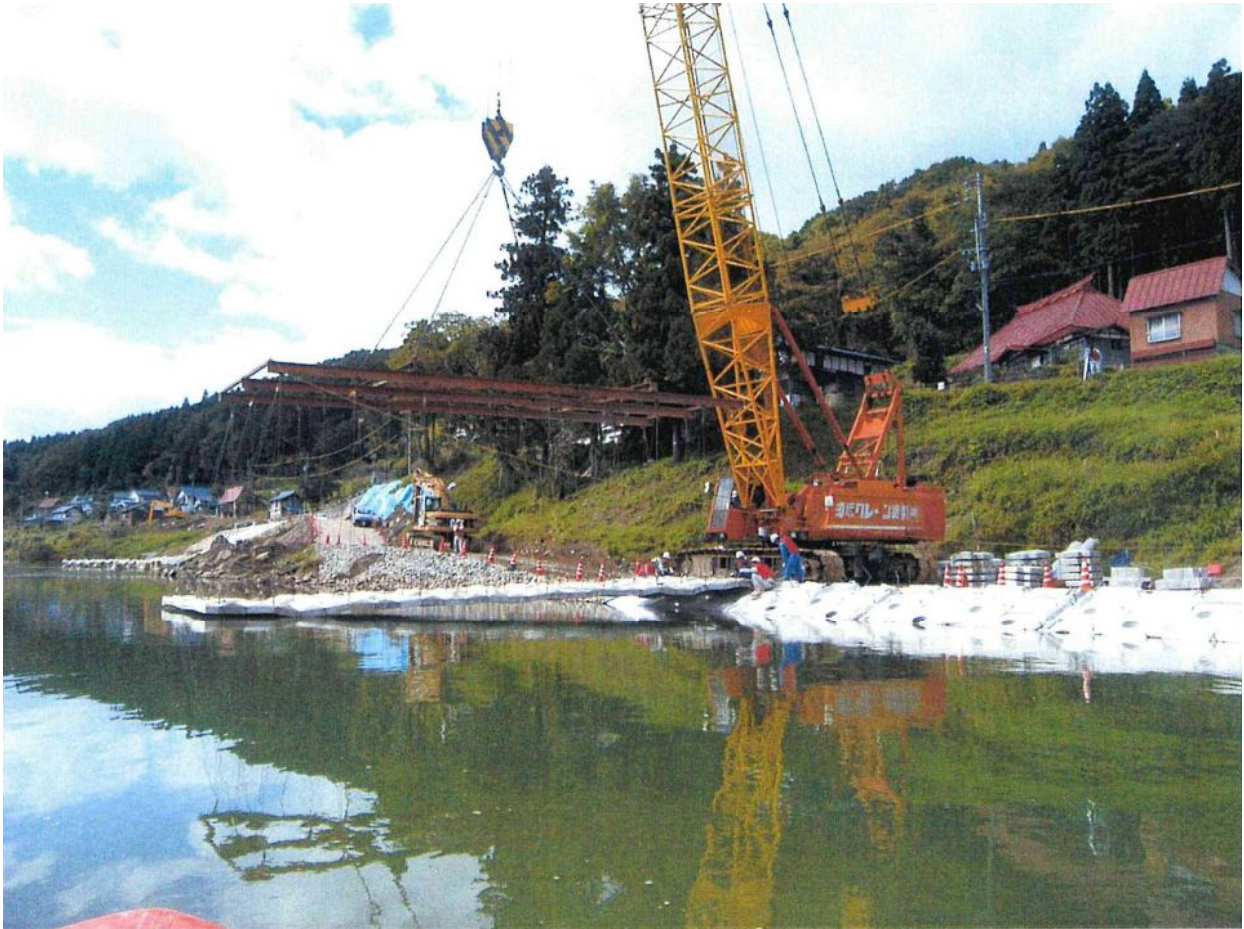
100 t 級クローラークレーンによる連節ブロック吊落とし
