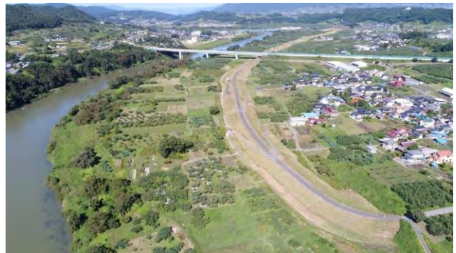
▲完成した千曲川 高丘地区堤防 (牛出・栗林地区から望む)
