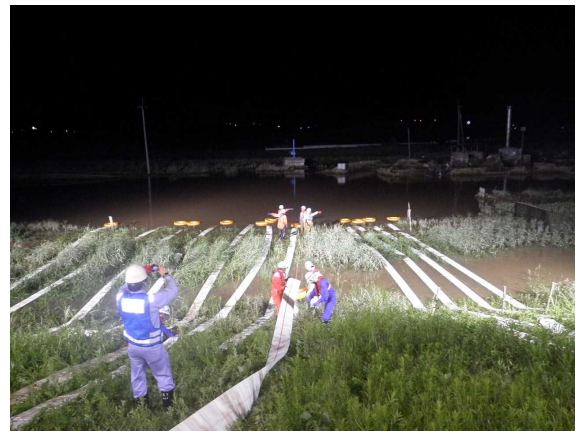
想定していなかった状況での排水作業
