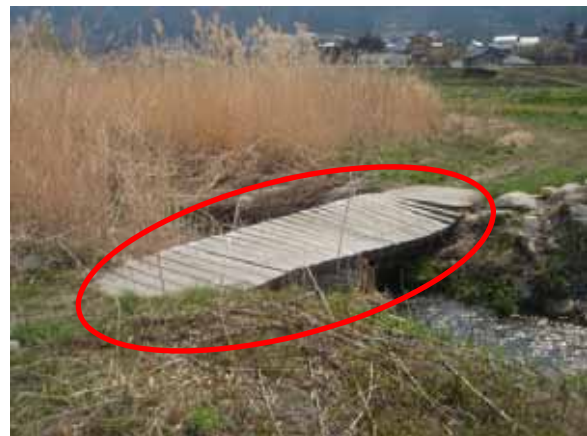
木橋の損傷状況（安曇野市中川手）
