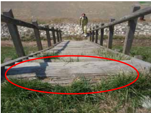
木製階段の点検状況（松本市島内地先）
