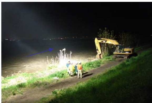
①春先の融雪出水、季節外れのまとまった降雨等で河岸欠損が徐々に進行。
