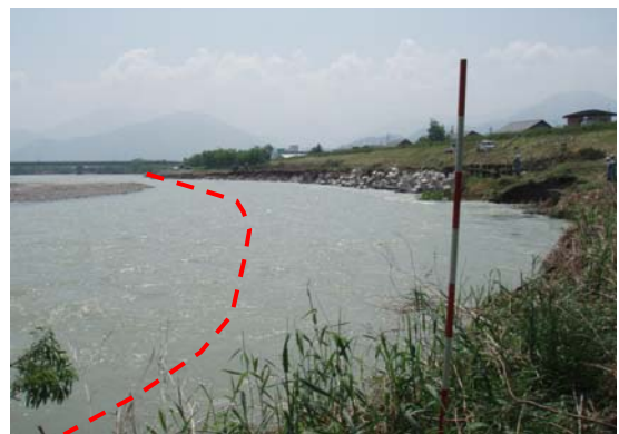
②5月29日の台風2号出水により河岸が大きく後退
