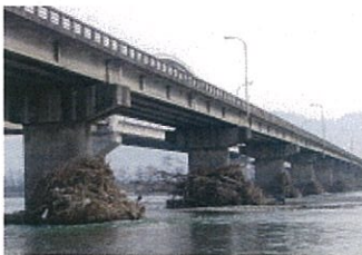
橋脚に堆積した流木
