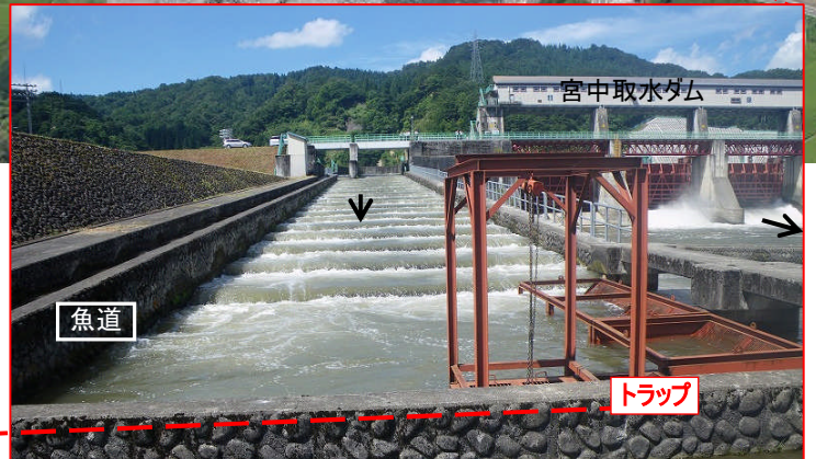
平成22年のサケ遡上状況調査におけるトラップ設置状況
