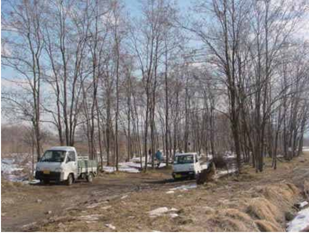
▲河道内樹木 伐採前
