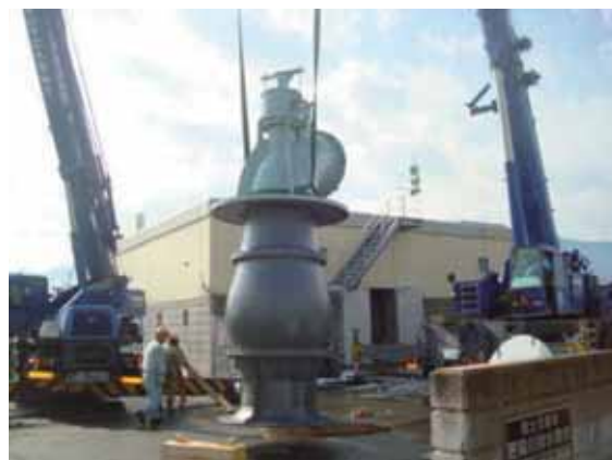
ポンプ増設の作業状況
