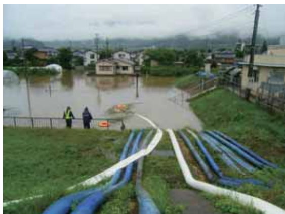
18年7月出水による堤内地の冠水状況
