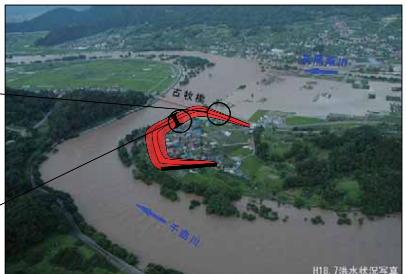
H18.7洪水状況写真
