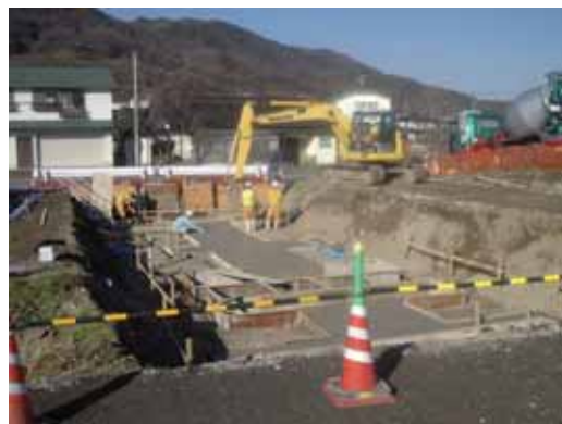
[排水樋門の施工状況]
