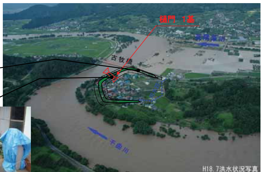
H18.7洪水状況写真
