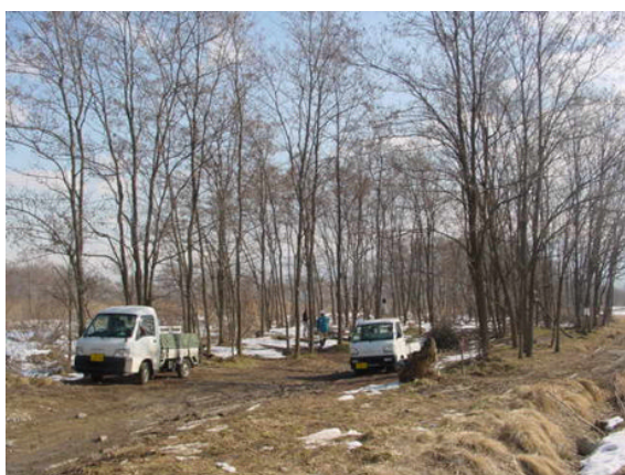
▲河道内樹木 伐採前
