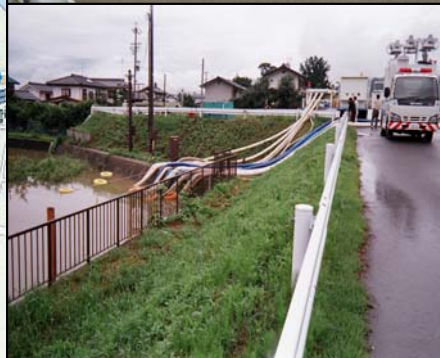
平成18年7月19日 岡田川樋門における排水作業
