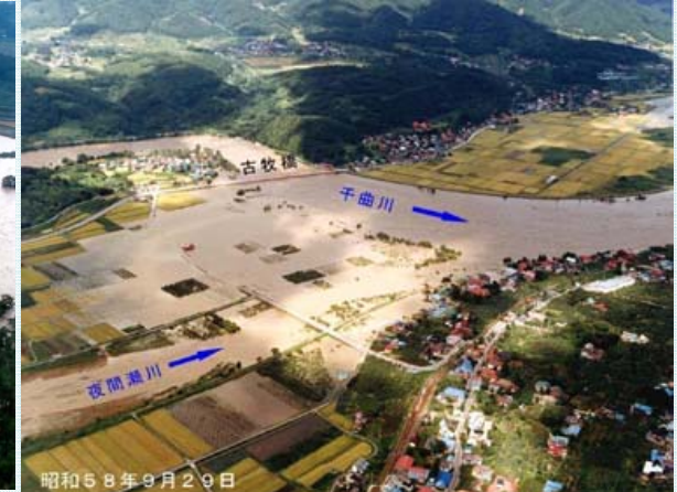
昭和58年 浸水状況
