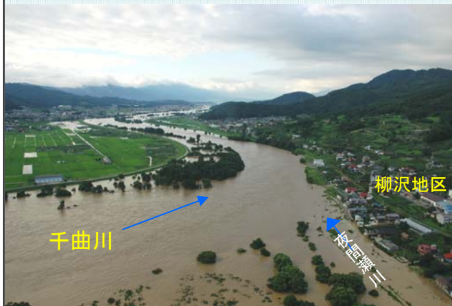
堤防整備中の柳沢地区 浸水状況 (H18年7月19日17時頃)
