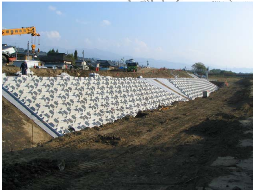
急ピッチで工事を進めています
