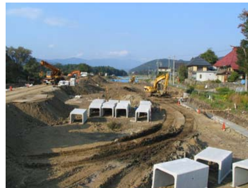
水路の施工状況
