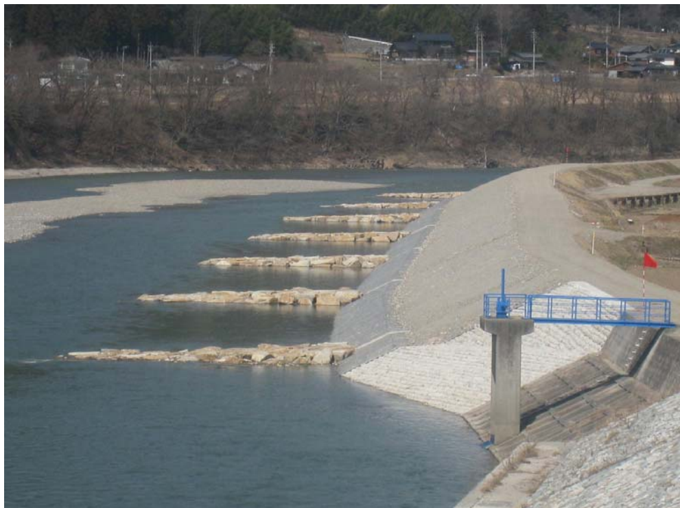
完成写真(上流より下流を望む)
