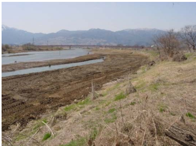
▲栗佐地区試験掘削後の状況
