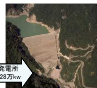
七倉ダム[東京電力HD株] (昭和54年度完成)
