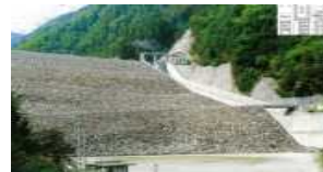
七倉ダム(発電) (昭和54年度完成)
