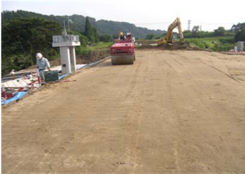
4tローラー締固め状況
