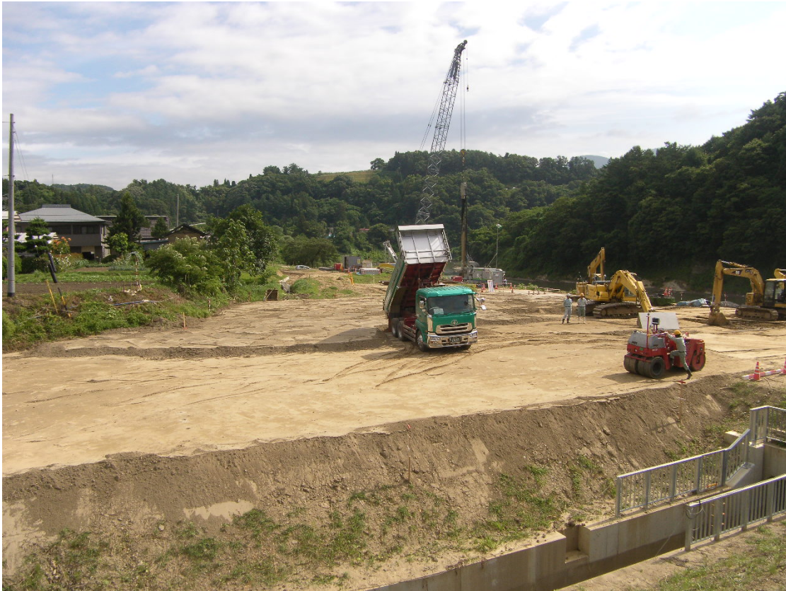
作業状況：土砂搬入
