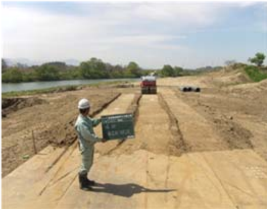
試験盛土状況
