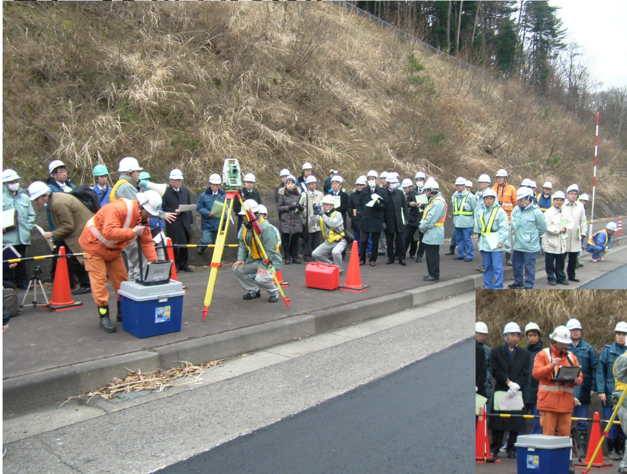
TSによる基層工の出来形測定
