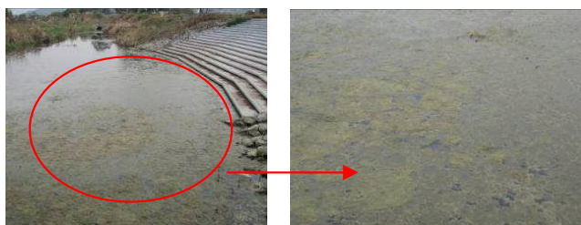
写真-1 改善前親水池状況 (藻が大量に発生)
