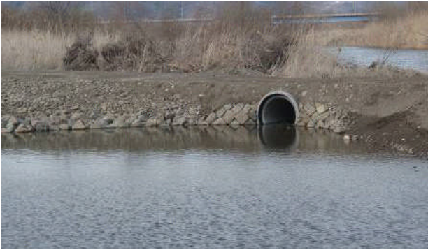
写真-7 流末調整後状況
