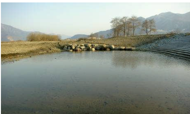
写真-8 改善後親水池状況
