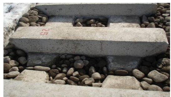
写真-5 礫による埋戻し状況
