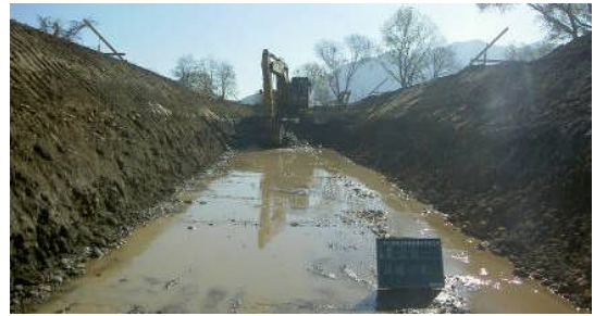
写真-3 伏流水を確認しながらの掘削状況
