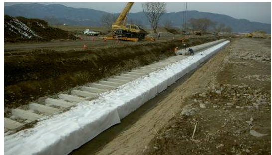
写真-4 吸い出し防止対策状況
