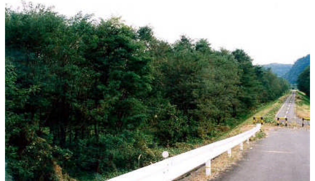
図-2 ハリエンジュの繁茂状況
