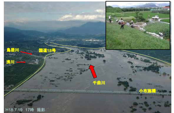
写真-1 平成18年7月出水状況と水防活動
