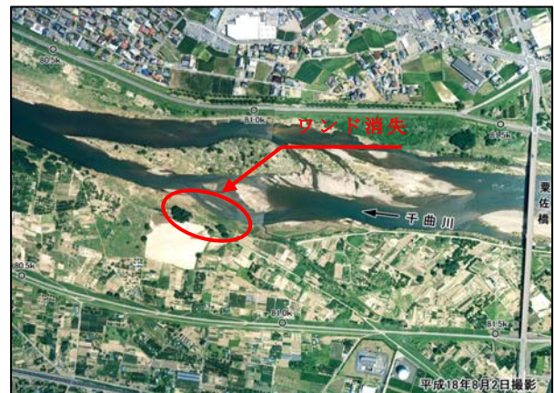
写真－9 平成18年8月2日撮影 平成18年7月豪雨により下流側 に造成したワンドが消失
