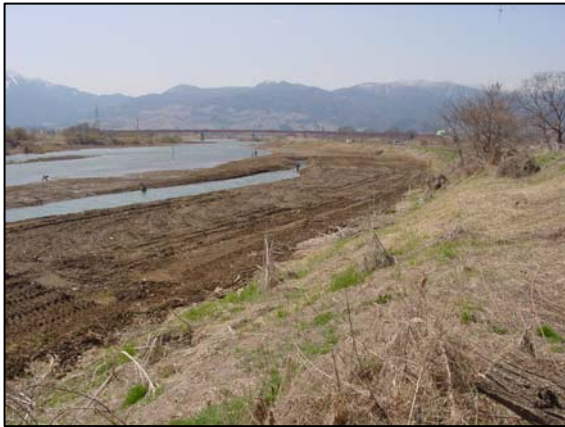
写真－2 平成18年4月6日撮影 掘削直後の状況。
