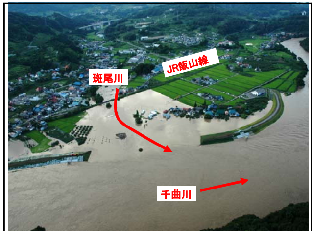
写真一 1 H18.7 替佐地区浸水状況
