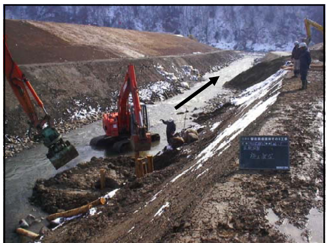
写真一 5 杭出水制施工状況
