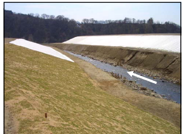
写真一 9 工事完成直後
