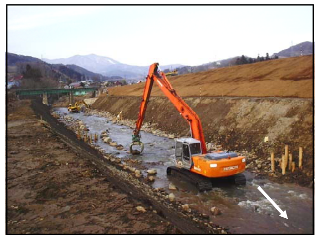
写真一 4 寄せ石施工状況
