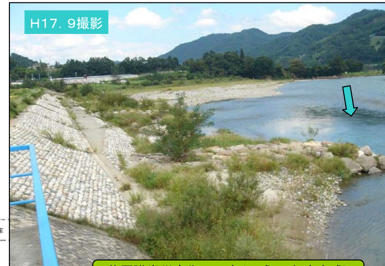
荻原護岸災害復旧工事(平成12年度完成) 犀川左岸56.5k付近
