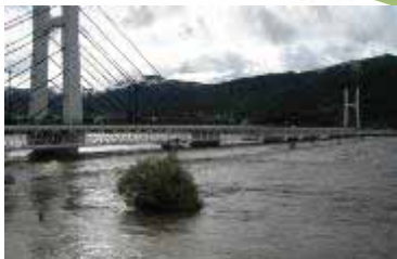
杭瀬下観測所付近の千曲橋
