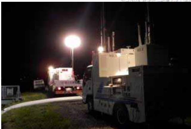
中野市上今井地先 本沢川樋門での排水状況
