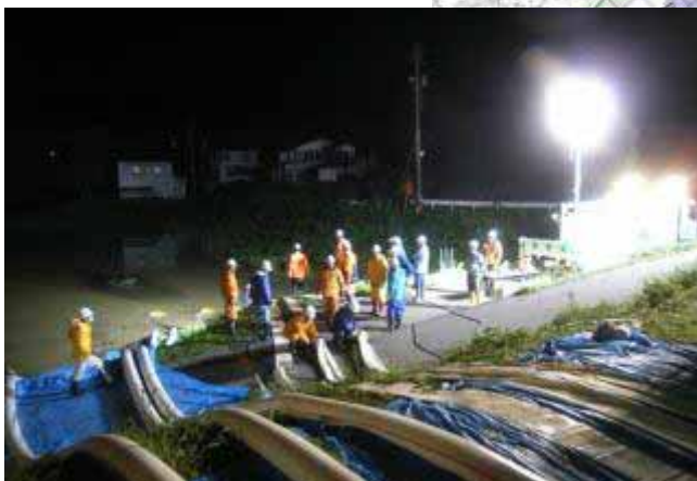
飯山市戸狩地先 今井川樋管での排水状況
