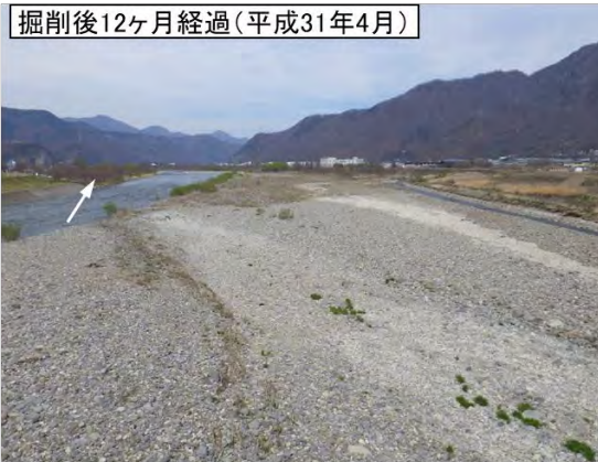
掘削後12ヶ月経過（平成31年4月） 砂礫河原が維持されている
