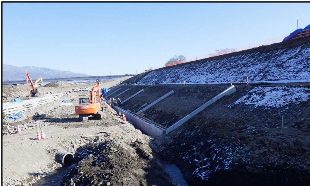
当工事は、令和元年10月の台風19号により被災した箇所、上田市中之条(100.0+272m～100.0+341m)及び上田市御所(102.5+181m～102.5+236m)の護岸復旧工事です。
