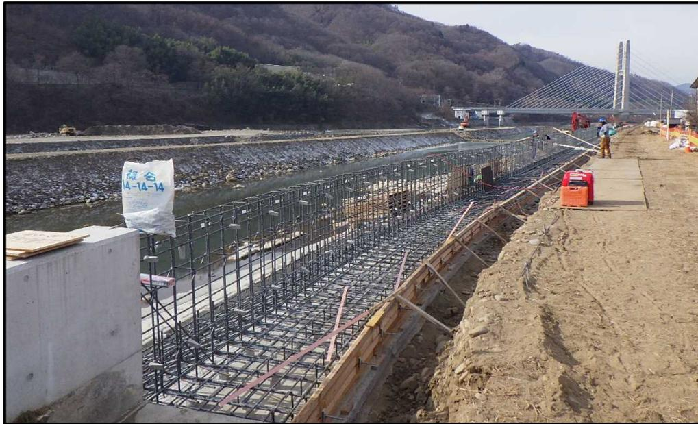
当工事は、令和元年10月の台風19号により被災した箇所、上田市小牧(105.5+310m～105.6+350m)、(105.5+350m～105.6+380m)、上田市国分(107+150m～107+410m)の護岸復旧工事です。
