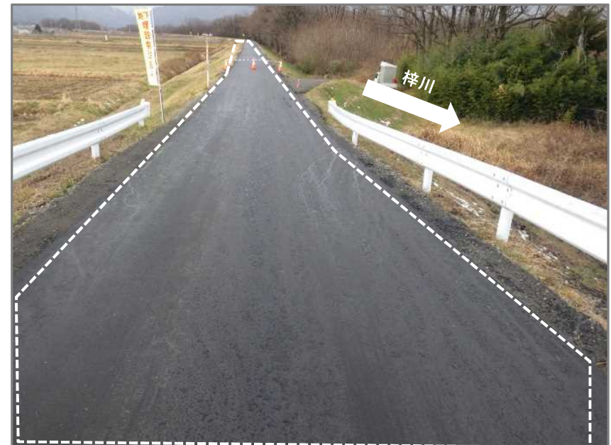
12月末現場状況 舗設完了(下島橋)
