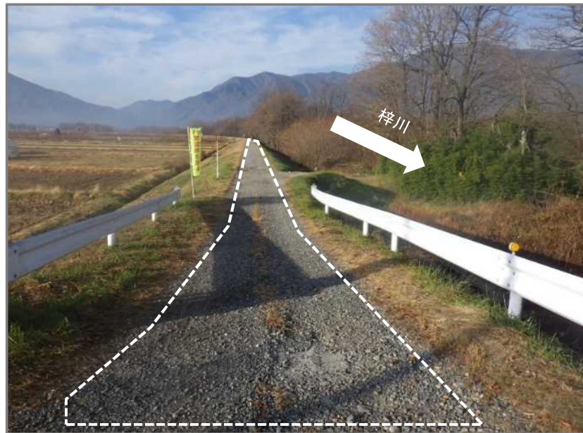
11月末現場状況 着手前(下島橋)
